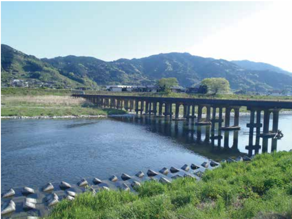
勝浦川の沈下橋
