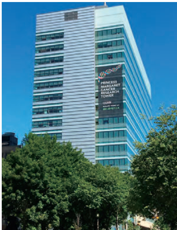
ラボが入る研究棟
